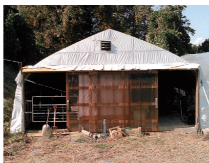
換気扇を設置したハウス牛舎。暖かい日には空気を入れ換えましょう
