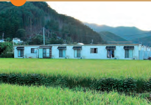
仮設住宅での生活は続いている (平成27年9月)
