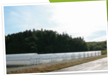
井戸を掘削し給水設備も万全のハウス
