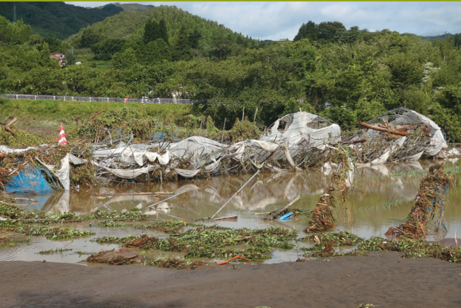
流木などで押しつぶされたパイプハウス(宮古市)
