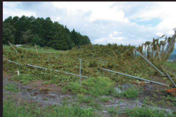
倒壊したホップ棚(遠野市)
