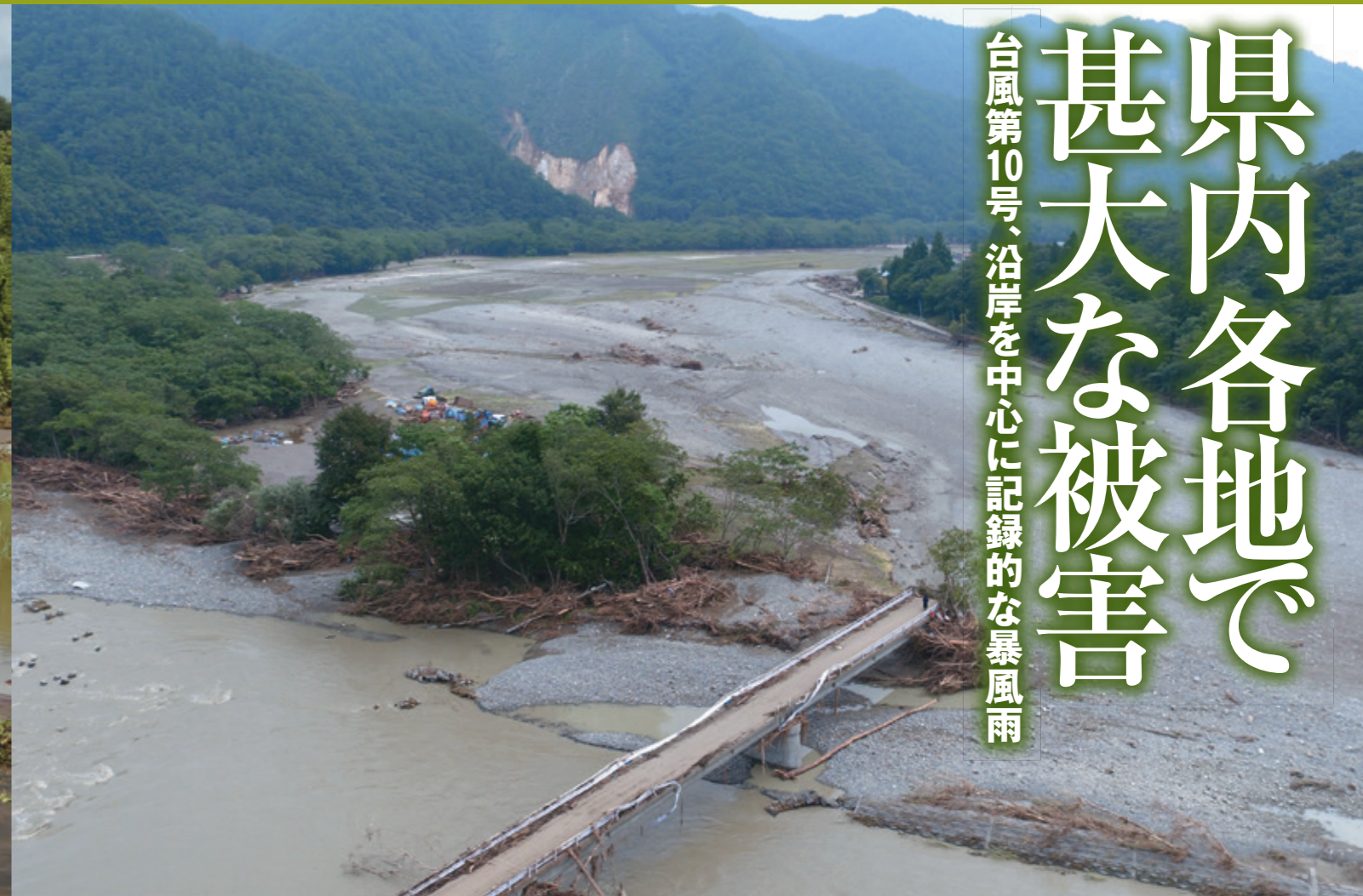
河川の氾濫により水田(写真奥)が土砂に埋め尽くされた小本川流域(岩泉町)
