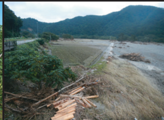
土砂が流入した水田(宮古市)
