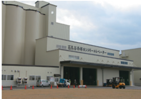
最新の処理設備が導入されています
