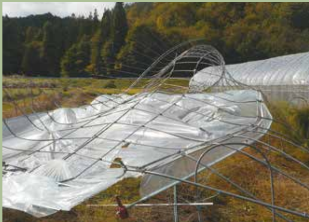
強風で倒壊したハウス（遠野市）
