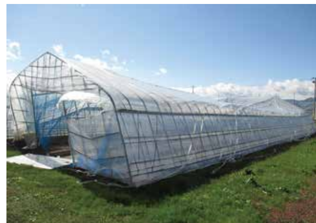
強風でパイプが歪んだハウス
