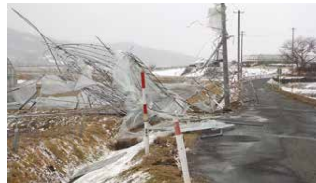
強風により全壊したハウス（令和3年2月16日撮影・遠野市）
