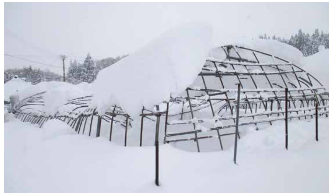
未被覆のハウスも大雪で倒壊（令和3年2月8日撮影・北上市）
