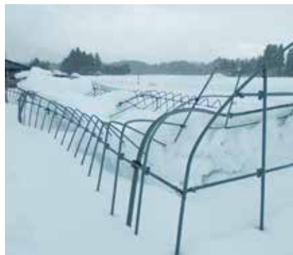
大雪で潰れたビニールを被覆していないハウス（金ケ崎町）
